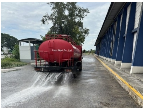
ภาพที่ 2.2-8 การฉีดพรมน้ำเพื่อลดฝุ่นละออง
