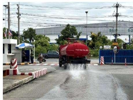
ภาพที่ 2.2-8 การฉีดพรมน้ำเพื่อลดฝุ่นละออง
