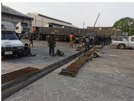
ภาพที่ 2.2-31 การตรวจสอบและทำความสะอาดรางระบายน้ำ
