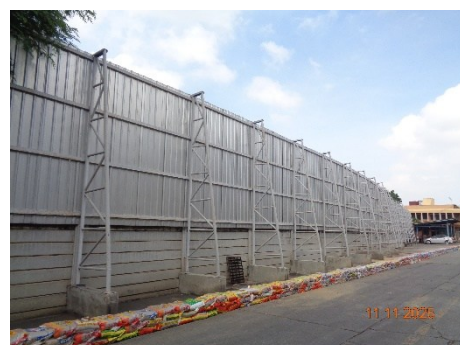
ภาพที่ 2.2-13 แนวกำแพงป้องกันฝุ่นสูงไม่น้อยกว่า 6 เมตร ตลอดแนวรั้วที่ติดชุมชน
