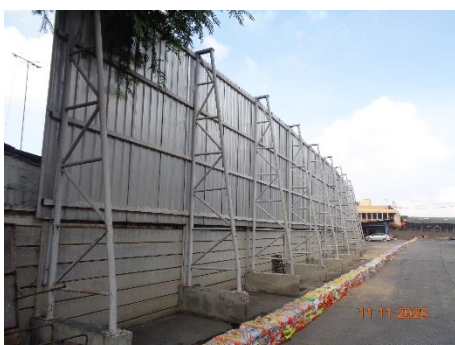
ภาพที่ 2.2-13 แนวกำแพงป้องกันฝุ่นสูงไม่น้อยกว่า 6 เมตร ตลอดแนวรั้วที่ติดชุมชน
