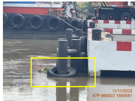
ภาพที่ 2.2-44 หลักกันเรือกระแทก
