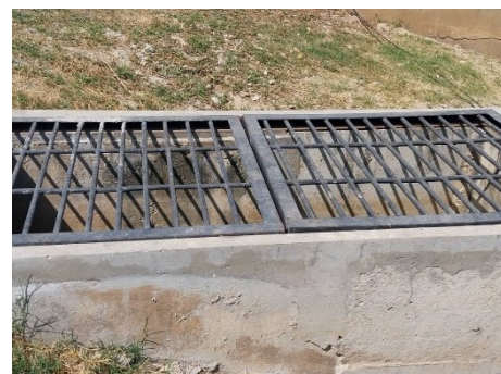
ภาพที่ 2.2-19 บ่อพักน้ำก่อนปล่อยออกนอกโครงการ
