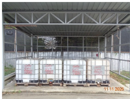
ภาพที่ 2.2-22 ถังรวบรวมน้ำมันจากเรือโป๊ะและเรือลากจูง
