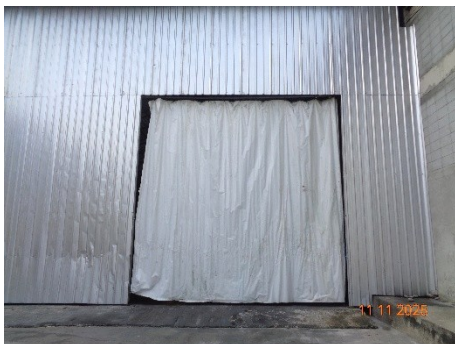
ภาพที่ 2.2-7 ม่านผ้าใบพลาสติกและประตูเหล็กป้องกันฝุ่นอาคารโกดัง
